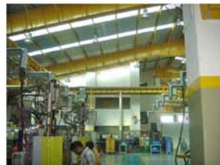
工場屋根の日光による採光 (左)
