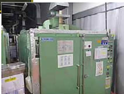
二次加硫炉の断熱 設備を断熱材で覆い、 周囲を不燃性生地で囲う (下)
