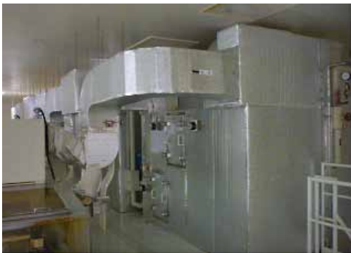
大型コーター装置の断熱
