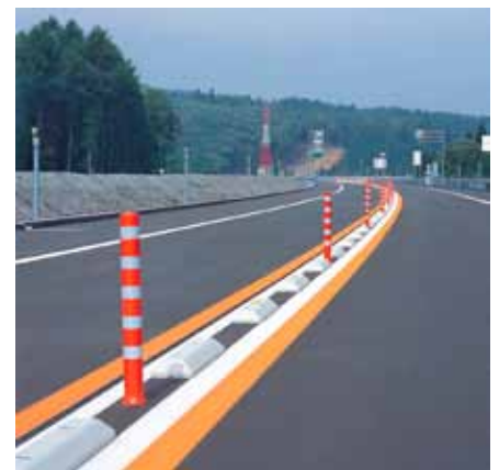
ポストコーンと中央分離帯ブロック
